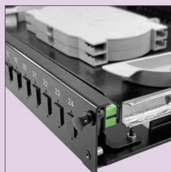
Montaje adaptadores sin sobresalir
